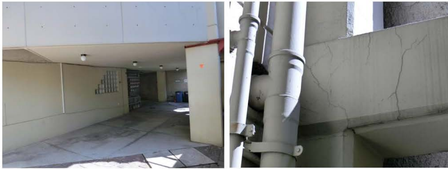
1階の駐車スペース
