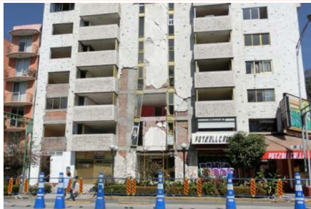
非構造壁のせん断破壊と仕上げ材の剥落
