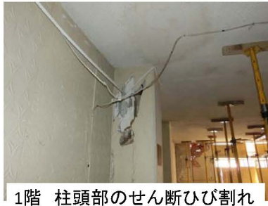
非構造壁のせん断破壊と仕上げ材の剥落
